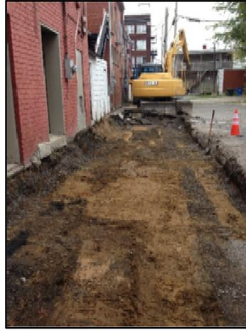
*Positionnement d'un géotextile de support du sol.*
